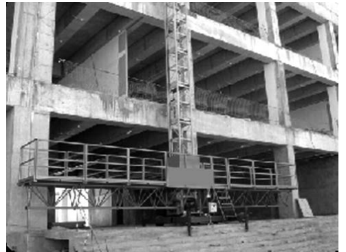
Dış cephede kurulu asansör tip hareketli iskele
