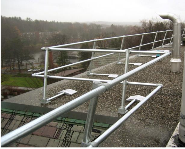
Şekil 14. Çatıdaki Daimi Kalıcı Korkuluk Örneği (Kaynak: KeeGuard Company)
